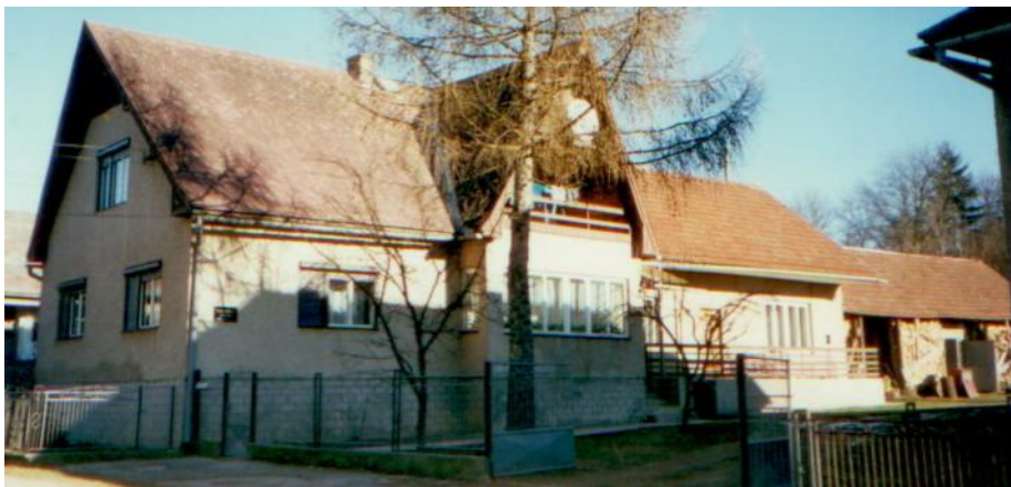
Budova novej fary
