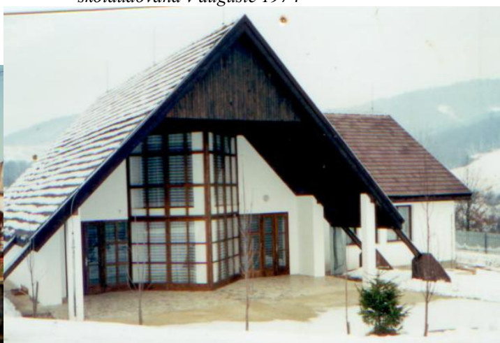
Budova Domu Smútku dokončená výstavba v roku 1998
